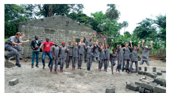
Die Jugendlichen der Gemeinde La Sarraz haben beim Bau einer Maniok-Verarbeitungsanlage in Guinea
